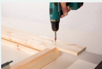
7. Anschrauben der Blende oben
