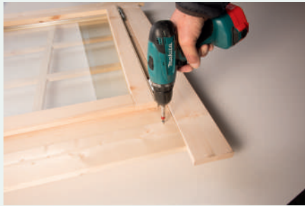
4. Fertig montierte Blenden, Fenster innen
