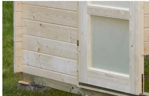
Nun werden schrittweise die Wände hochgezogen. Erst wenn diese etwa 40-50 cm aufgebaut sind (ca.4-5 Reihen), ist eine Ausrichtung mit der Wasserwaage durch das größere Eigengewicht sinnvoll.
