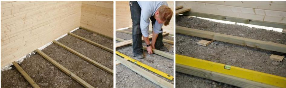
Nun kann der Bodenbelag genagelt oder verschraubt werden. Im Bereich des Türdurchgangs achten Sie auf einen sauberen Anschluss an die Edelstahlschiene, da an dieser Stelle keine Fussleisten vorgesehen sind. Evtl. kann es erforderlich werden, das letzte Brett in der Breite etwas an zu passen. **Siehe Abb. unten**
