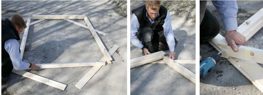
Der so zusammengesetzte Türrahmen wird von oben auf die halb aufgebaute Wand geschoben, und nicht mit den Wänden verschraubt. **Abb. rechts**
