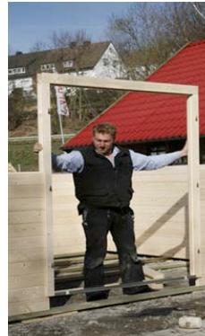
Mit Hilfe eines Assistenten prüfen Sie nun das "**Kreuzmaß**". Mit einem Maßband messen Sie die **Entfernung der gegenüberliegenden Ecken des Hauses**. Wenn die Maße gleich sind, steht das Haus exakt im **rechten Winkel**. Das ist wichtig für die spätere Montage und Passgenauigkeit des Daches.
